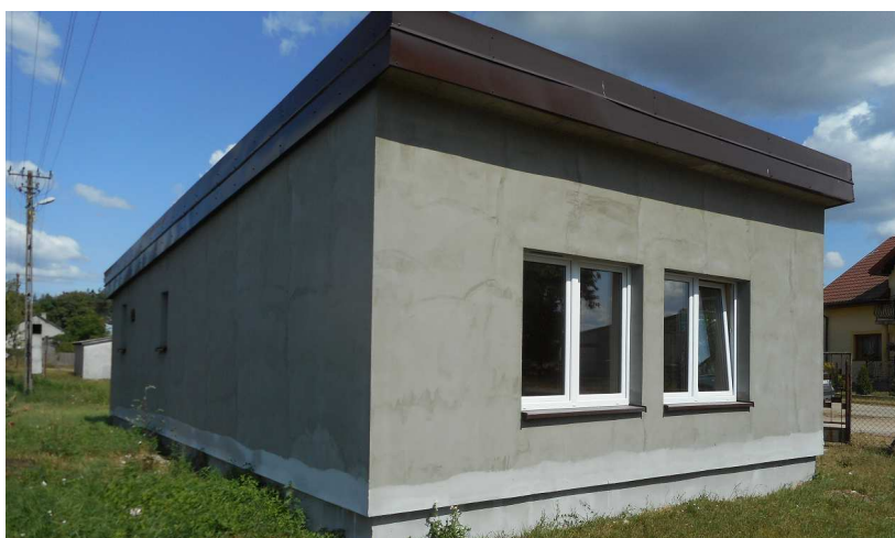
Widok budynku od strony południowo-zachodniej i północno-zachodniej
