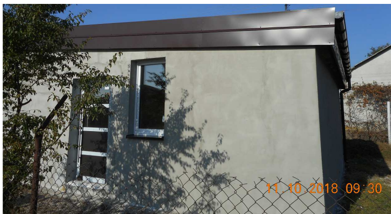
Widok budynku od strony południowo-wschodniej i północno-wschodniej
