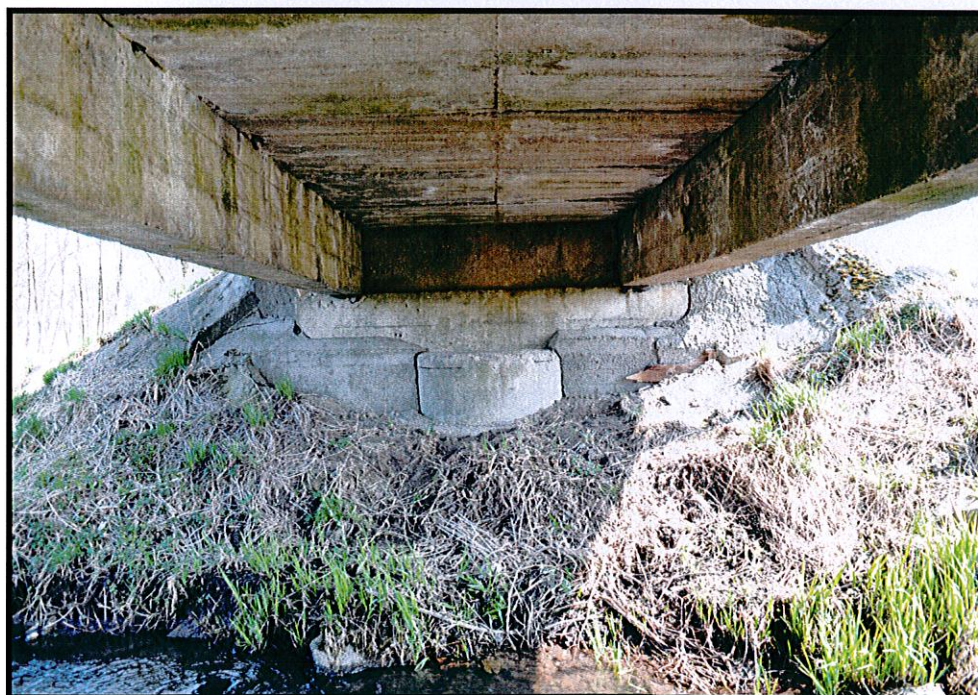
Fot. 6. Konstrukcja obiektu od spodu
