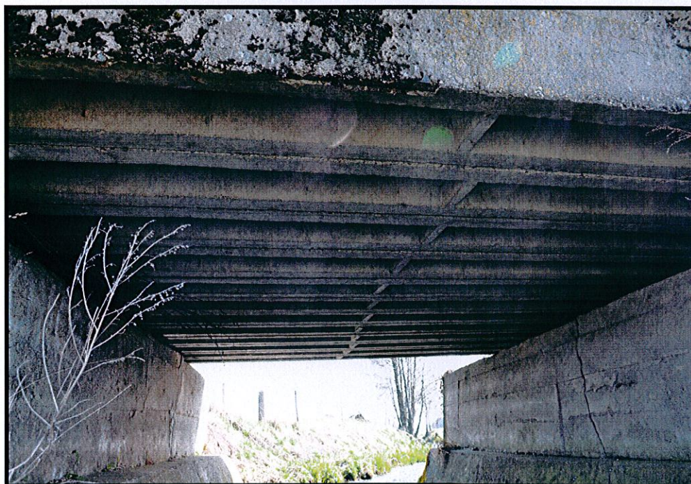
Fot. 6. Konstrukcja obiektu od spodu
