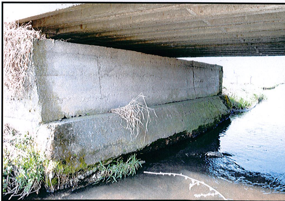
Fot. 8. Widok na prefabrykowane dźwigary pomostu oraz konstrukcję oporową
