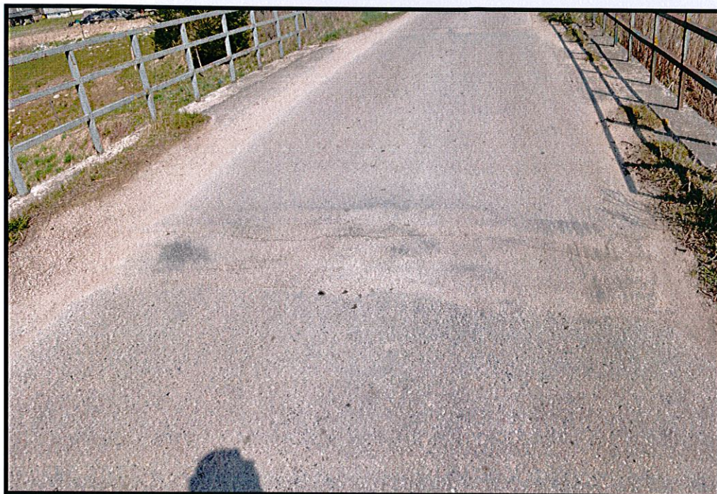
Fot. 9. Nawierzchnia, pobocza i balustrady
